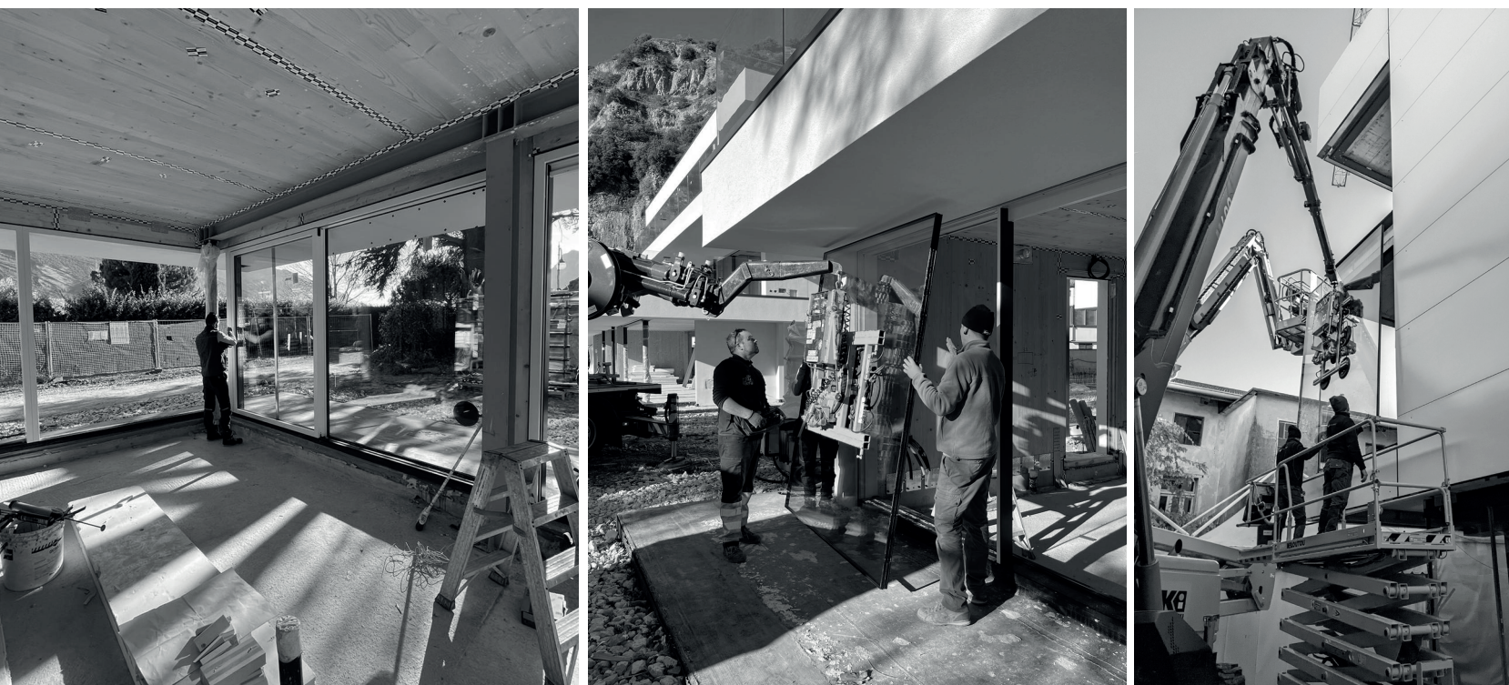
Immagini delle fasi di installazione delle vetrate
